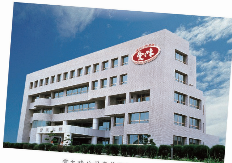
愛之味公司嘉義總廠行政大樓 AGV's Administrative Headquarters in Chiayi
