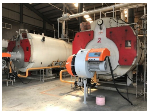
▲改造鍋爐燃燒機
